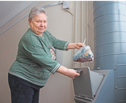
Ствол мусоропровода прочистили.
