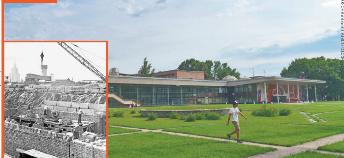
Московский дворец пионеров во время его строительства в 1959 году и сейчас. Спустя более 60 лет после открытия историческое здание решили бережно отреставрировать, сохранив все его ценные архитектурные детали. Работы должны закончиться в 2023 году.
