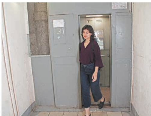
Работа подъёмника у жителей нареканий не вызывает.
