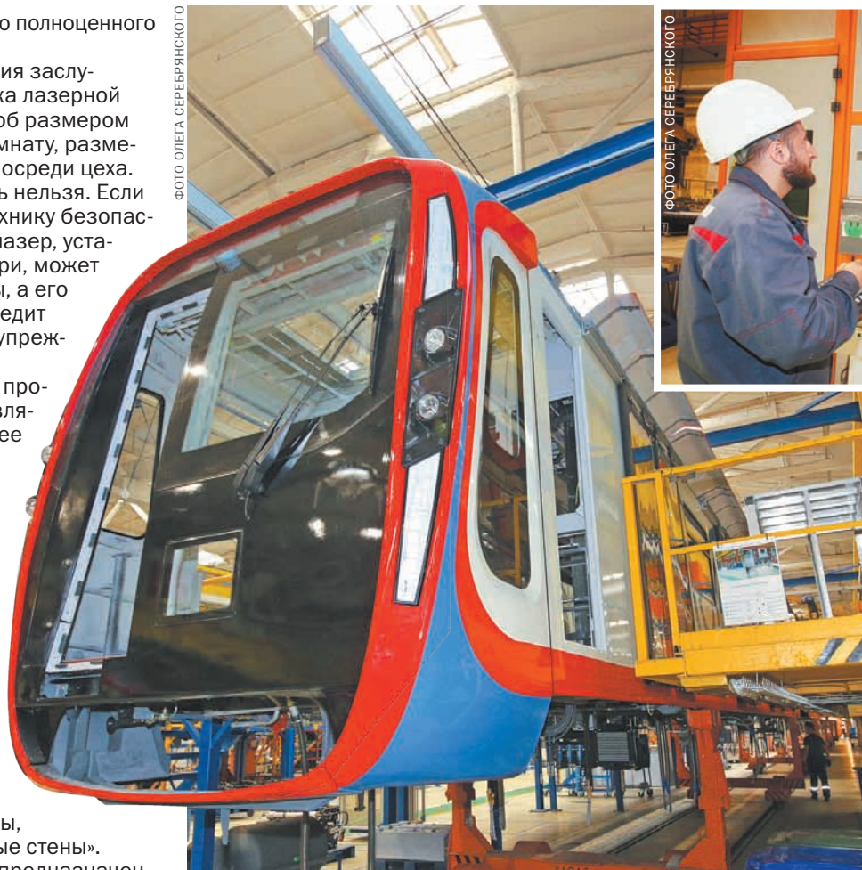
На финальном этапе специалисты монтируют оборудование под вагонами, прокладывают электрику, а также устанавливают двери и сиденья.
