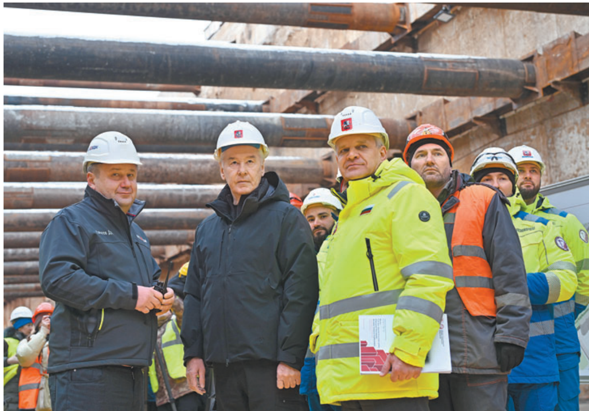
Сергей Собянин на месте строительства перегонного тоннеля между станциями «Народное Ополчение» и «Бульвар Генерала Карбышева». Работы выполнил проходческий комплекс «Натали».
