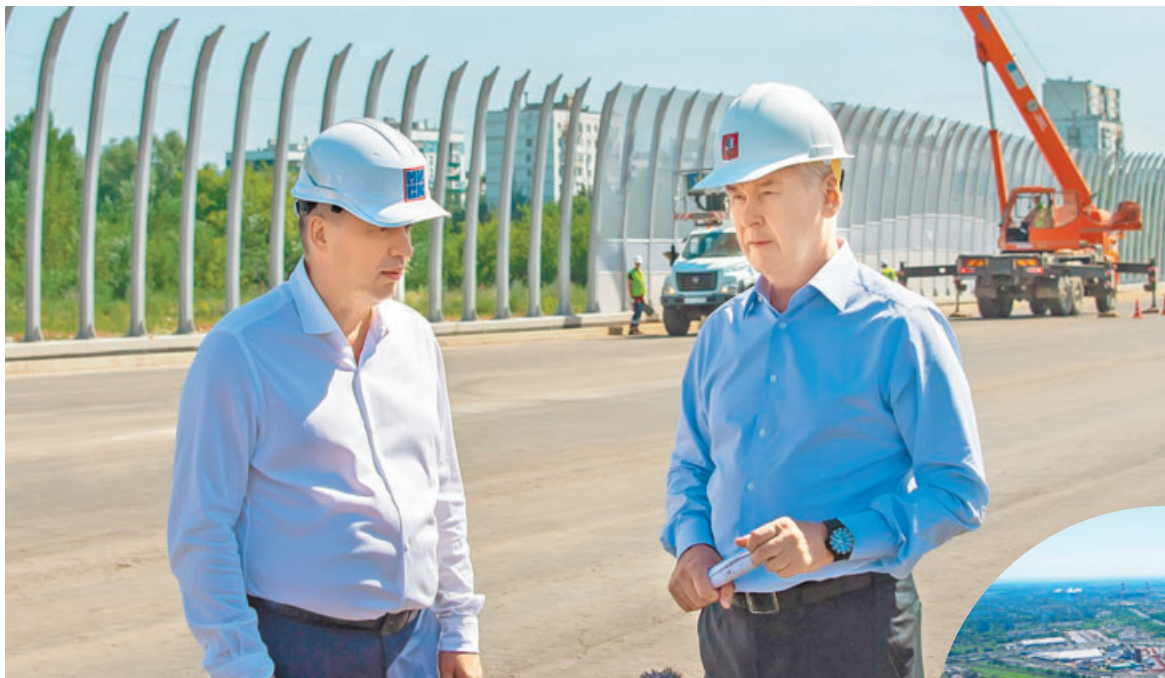
Сергей Собянин осмотрел строящийся участок новой дороги на юге столицы.
