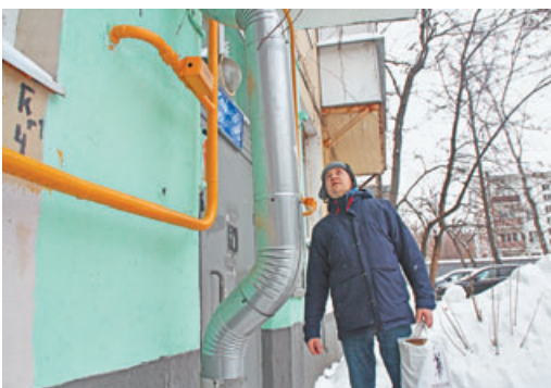
Водосток надёжно закрепили на стене дома.
