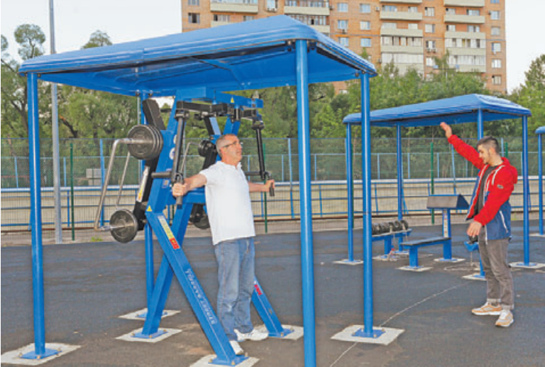
Первые 16 тренажёров смонтировали, скоро установят столы для тенниса и фитнес-станцию.
