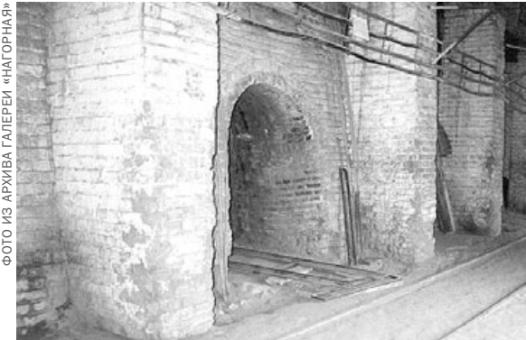
Камеры для обжига печей на Верхнекотельском заводе, 1889 год.
