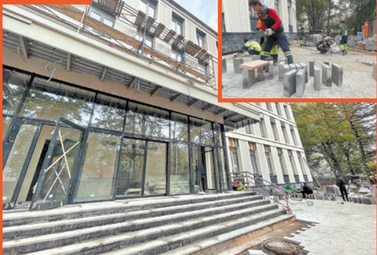
В филиале № 2 городской поликлиники № 22 (ул. Дмитрия Ульянова, д. 25) завершаются капитальный ремонт и модернизация. Сюда уже завезли мебель и медицинское оборудование. Рабочие наводят лоск и заканчивают благоустройство территории.
