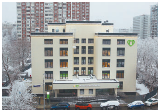
Вид снаружи на филиал № 4 Детской городской поликлиники № 81 после ремонта.
