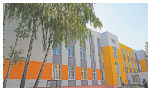
После ремонта в школе № 2103 откроются современные лаборатории и кабинеты 3D-моделирования.
