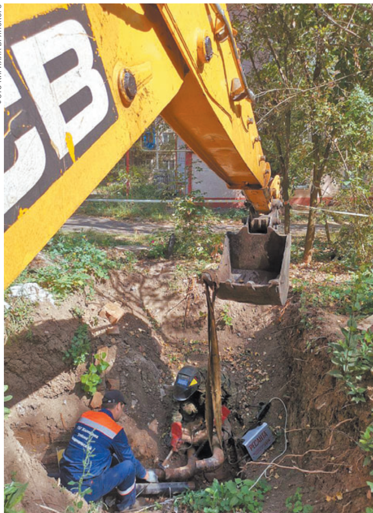
Ремонт тепломагистрали в Донецке на ул. Бобруйской, д. 33.
