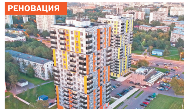
По программе реновации уже 4,1 тыс. семей получили ключи от новых квартир. На фото – новые дома в Котловке на Севастопольском просп. и ул. Дм. Ульянова.
