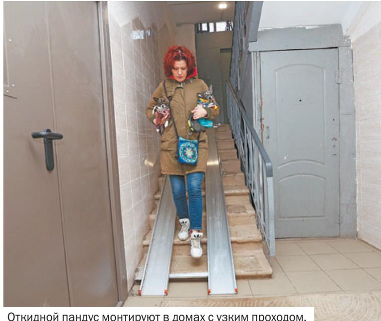
Откидной пандус монтируют в домах с узким проходом.
